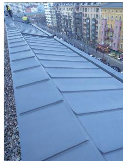
Sauber gearbeitete Anschlüsse und Flächenerteilungen am Übergang von den oberen Gauben zum anschließenden bekieten Flachdach.
