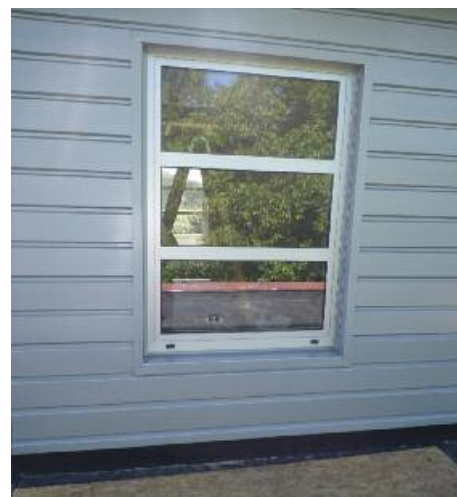
Die Verarbeitung an Fenstern, Gebäudeecken oder dem Sockel wird im Komplettsystem durch systemzugehörige Anschlussprofile vereinfacht.
