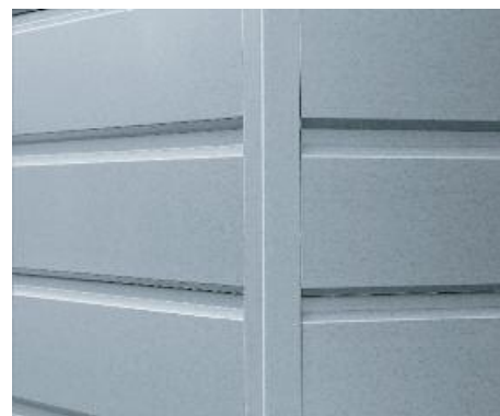
Die Verarbeitung an Fenstern, Gebäudeecken oder dem Sockel wird im Komplettsystem durch systemzugehörige Anschlussprofile vereinfacht.
