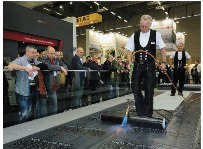
Praxisvorführung der neuen Oberlagsbahnen bei der Messe DACH + HOLZ 2014.
