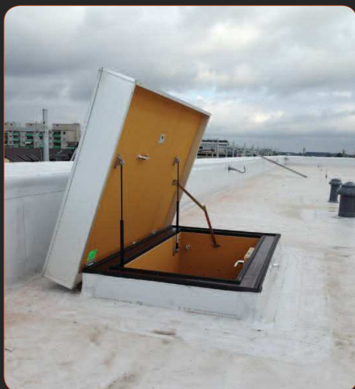
Flachdachausstieg mit Doppeldichtung
