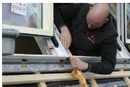
Strate dichtet den Einbaurahmen sorgfältig mit Klebeband ab
