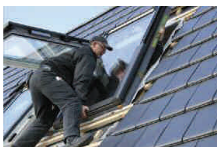
Das dritte und letzte Fenster der Fensterkombination wird auf die Einbauöffnung verlegt.
