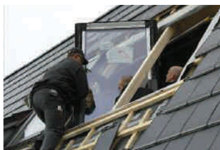
Das mittlere Fenster wird für die Verlegung von innen herausgehoben.
