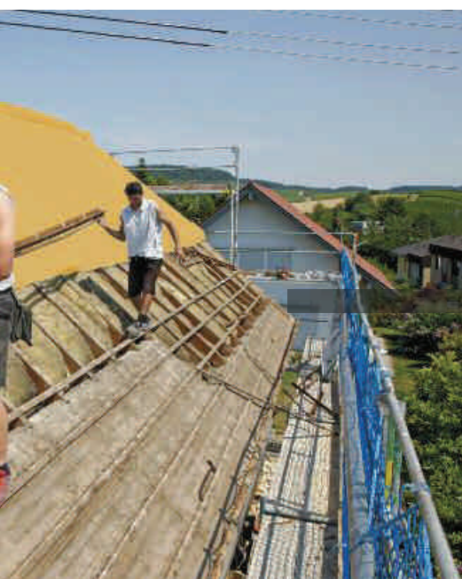
3. Die Aufsparrendämmelemente BauderPIR PLUS werden verlegt.
